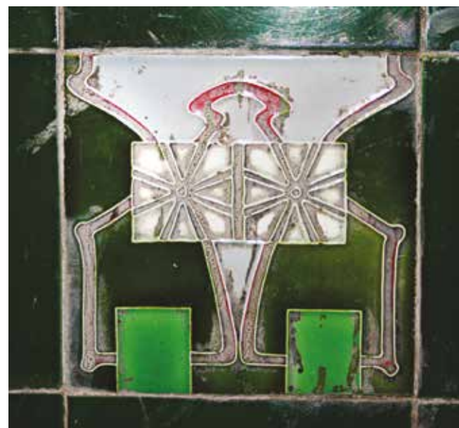
Керамічна плитка у вестибюлі будинку (Львів, вул. Саксаганського, 1). Поч. ХХ ст.
