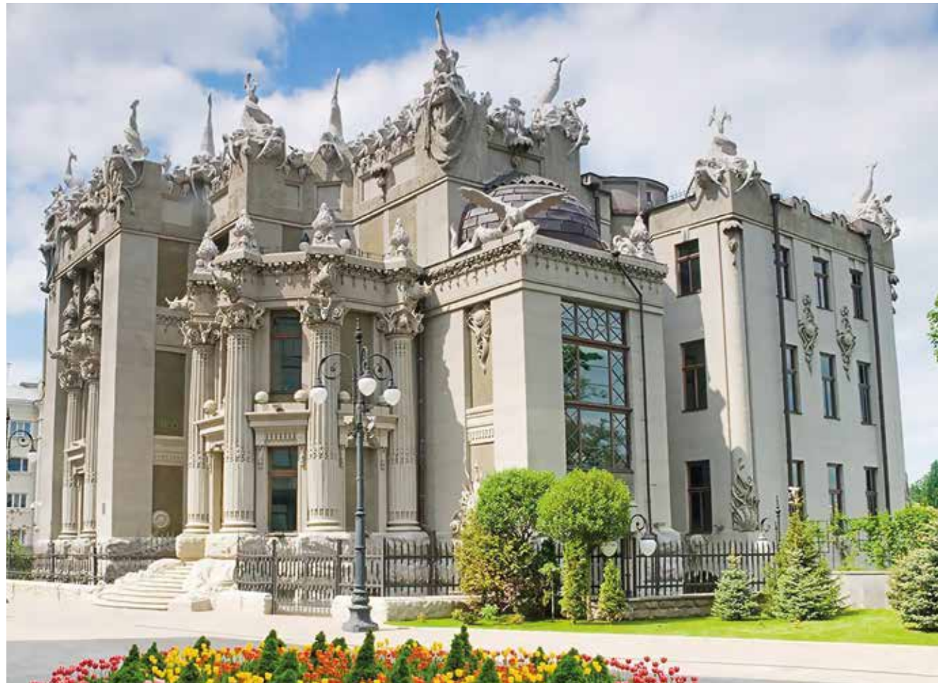
В. Городецький. Власний будинок (Київ, вул. Банкова). Загальний вигляд. 1901–1903
