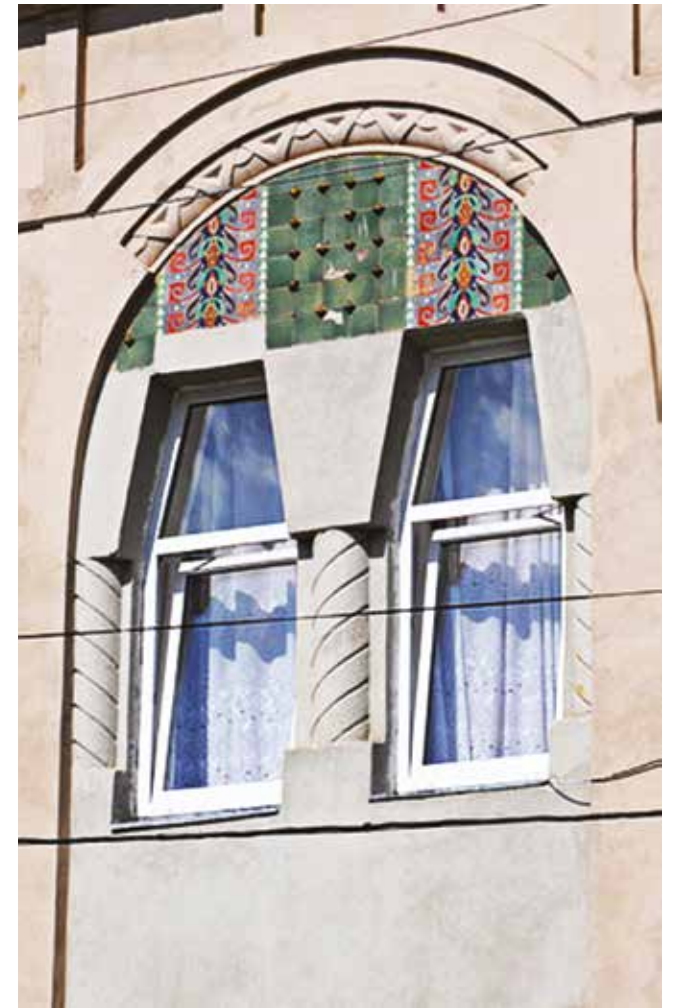
Керамічне облицювання на фасаді Народного дому (м. Кам'янка-Бузька, вул. Т. Шевченка, 11). Поч. ХХ ст.
