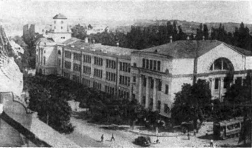
Будинок ВУАН (нині вул. Володимирська, 55)
